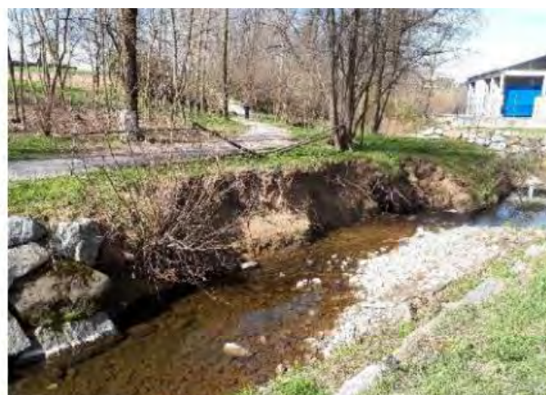
Figura 1-14 Criticità D2: Marcata erosione spondale in sinistra idrografica a monte e a valle di un tratto protetto da scogliera
