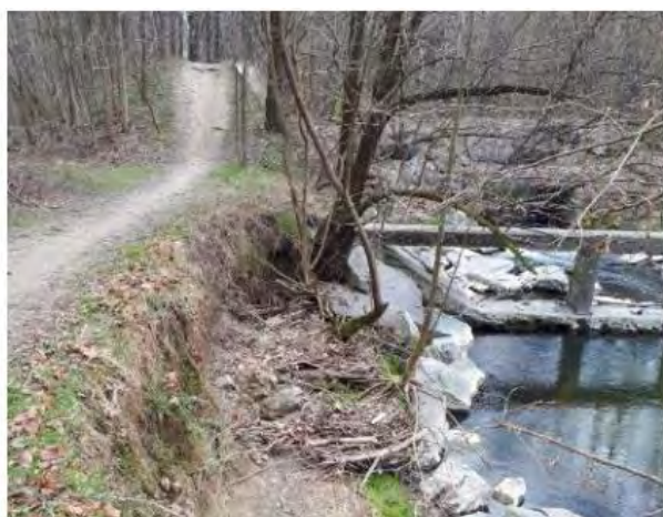
Figura 1-9 Criticità C1: Sponda destra del torrente a valle dell'opera trasversale interessata dalla presenza di piante e significativamente erosa.
