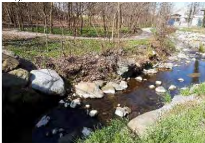
Figura 1-13 Criticità D2: Tratto di scogliera in parte collassata a valle di un attraversamento pedonale
