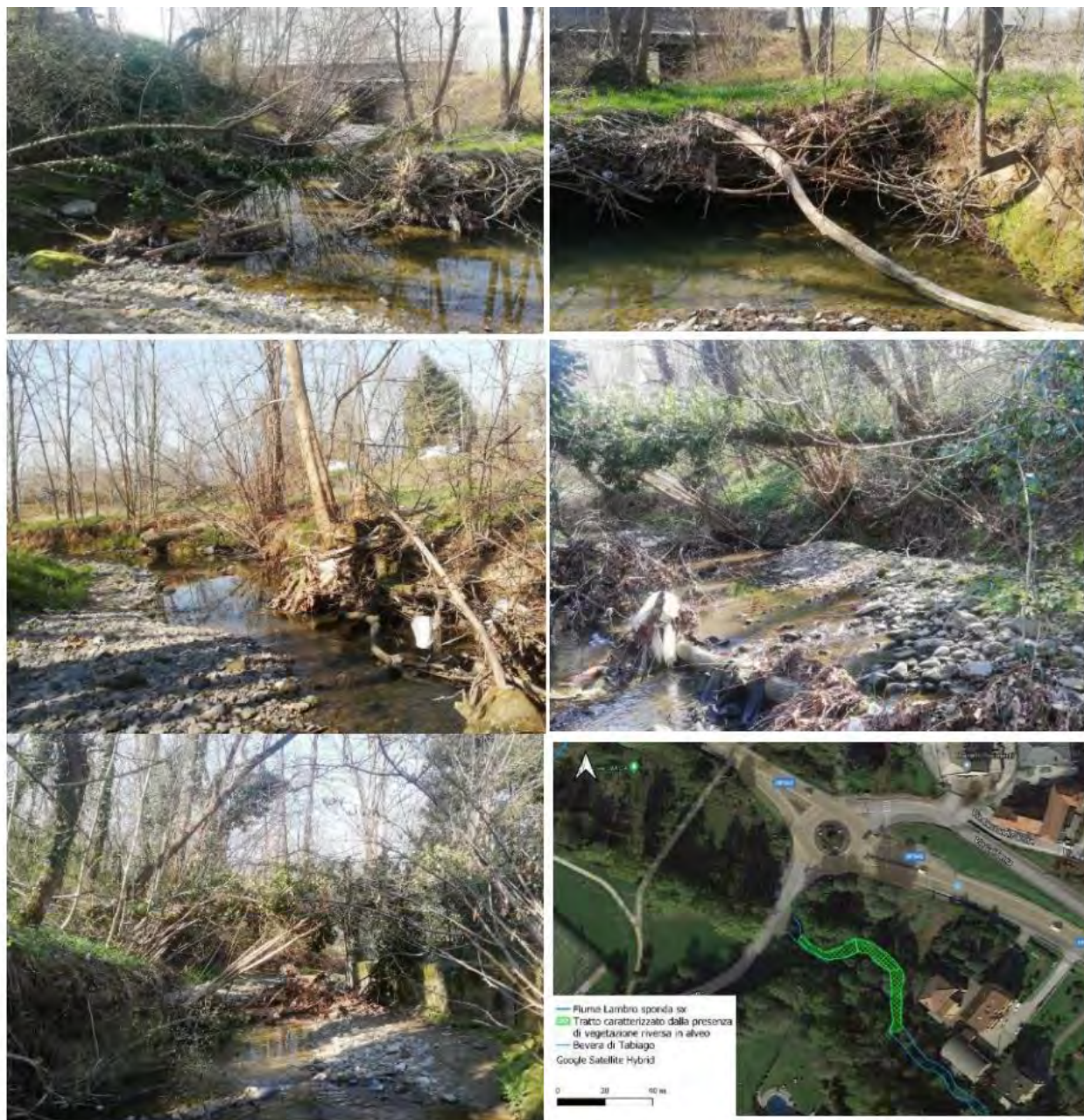
Figura 1-19 Criticità E1: Tratto immediatamente a monte dell'attraversamento stradale interessato dalla presenza d. abbondante vegetazione pericolante e riversa in alveo.
