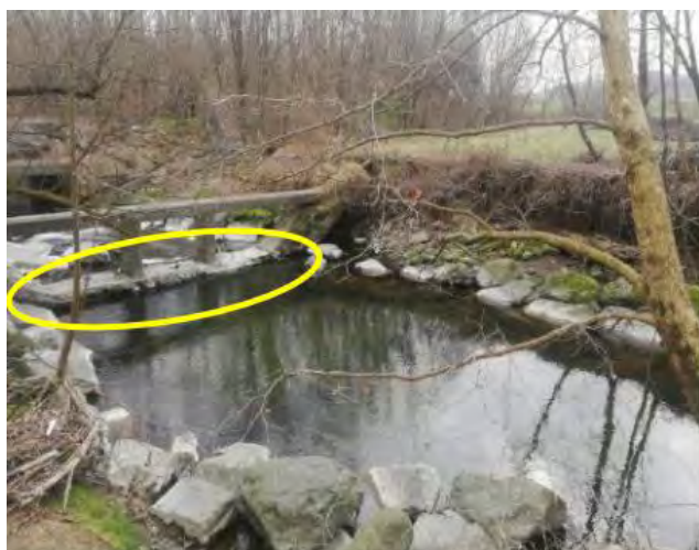
Figura 1-8 Criticità C1: Sponda sinistra della Bevera e opera trasversale soggetta a marcata erosione. In giallo è evidenziata l'instabilità alla base della briaglia.
