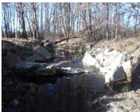
Figura 1-16 Criticità D3: Presenza significativa di vegetazione riversa in alveo e di una scogliera in parte collassata in alveo
