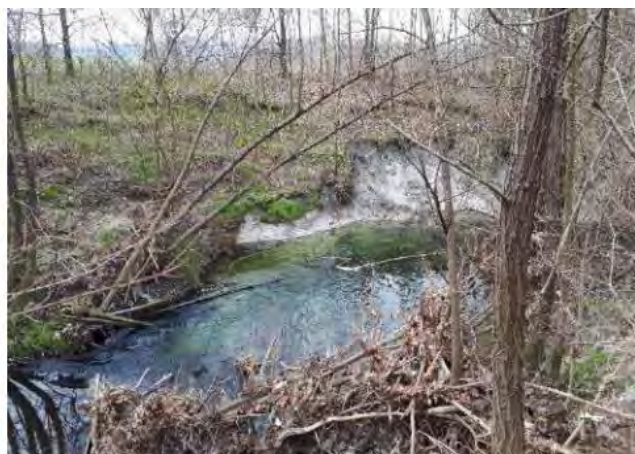
Figura 1-10 Scarsa manutenzione della vegetazione all'interno della vasca di laminazione lungo il torrente Bevera.
